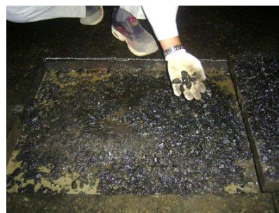
写真-1 水分の浸入による基層のはく離
