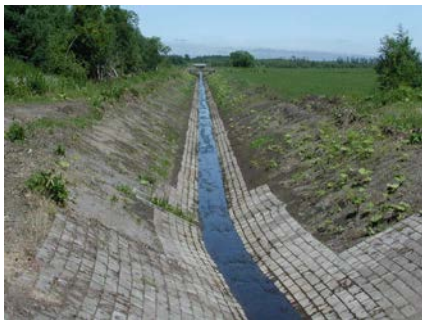
写真-1 連節ブロック型排水路
