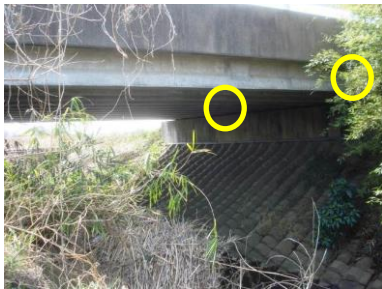
図-4.4 小河川に架かる橋梁での観測 (PC 桁端部の桁間および北側面ウェブ)
