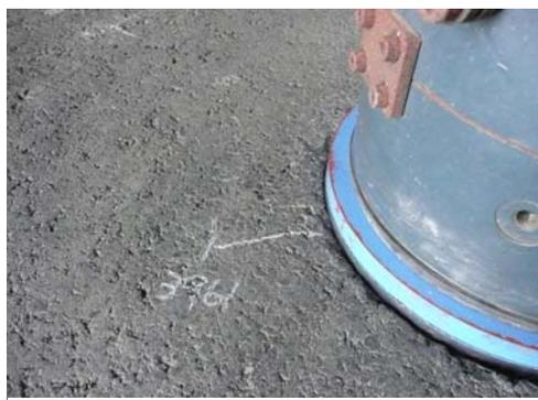
写真-2 微細なひび割れ発生状況
