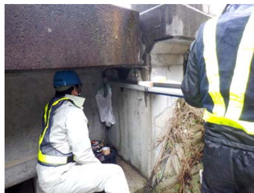
写真-7 ポリエチレン製排水装置の設置作業
