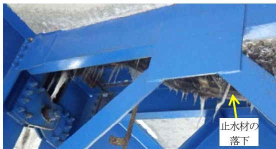
写真-2 伸縮装置からの漏水状況 (写真-1の矢印箇所、後付けの止水材が部分的に外れて、垂れ下がっていた。後述のC橋)
