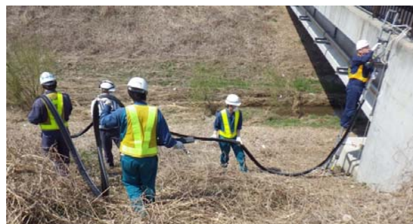
写真-6 ゴム製排水装置の設置作業
