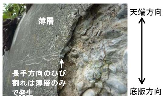
図-10 側壁表面部の薄層
