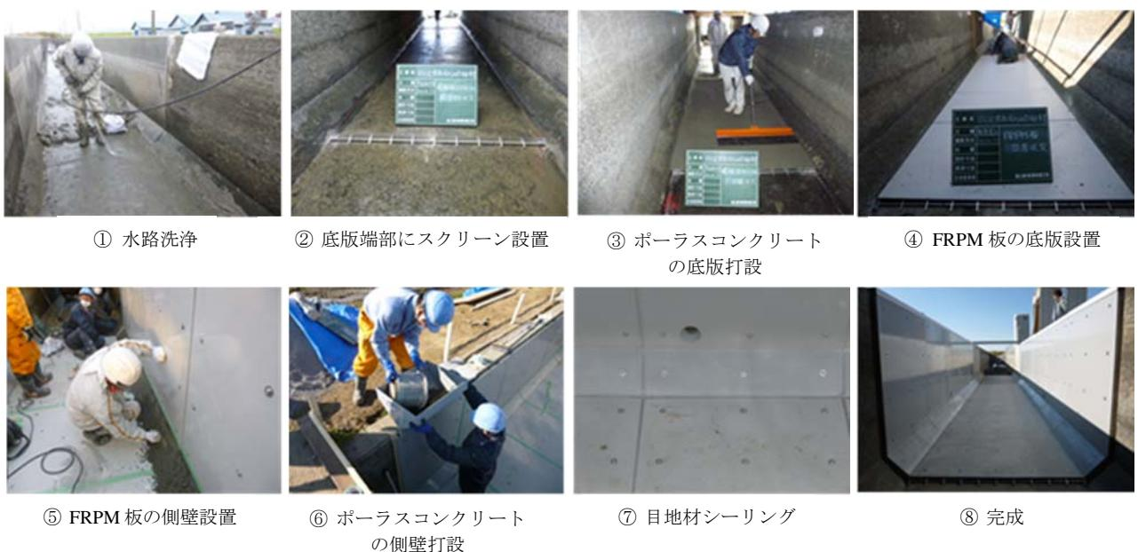
図-89 試験施工における水路更生工法の作業手順
