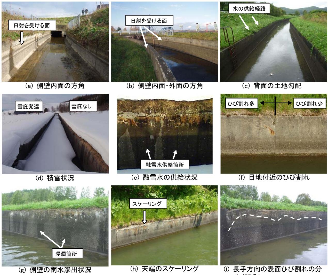
図-13 RC 開水路の凍害診断における目視調査のポイント
