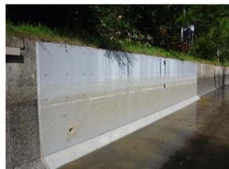
図-67 FRPM板の施工 7年後の状況（南面）
