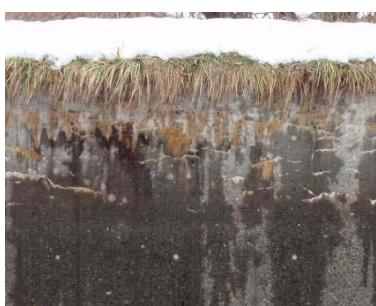
図-9 開水路側壁の凍害によるひび割れ発生状況
