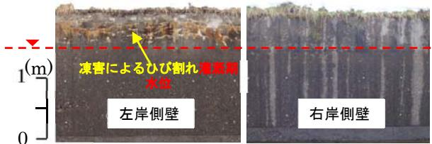
図-2 観測箇所の水路側壁の状況
