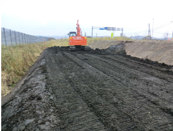
図-25 2次盛土の施工状況
