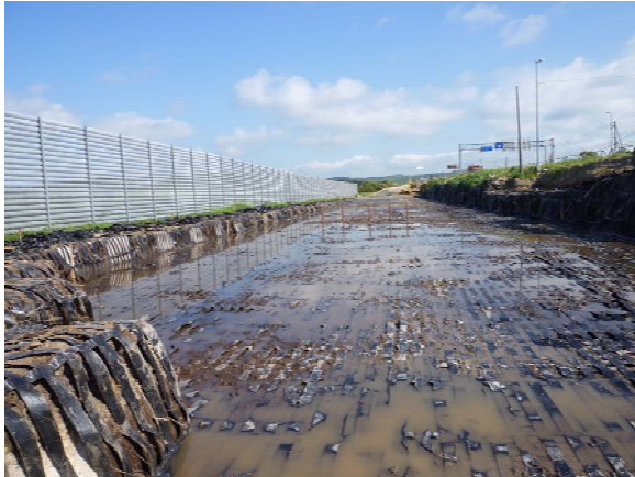
図-24 ジオテキスタイル敷設状況
