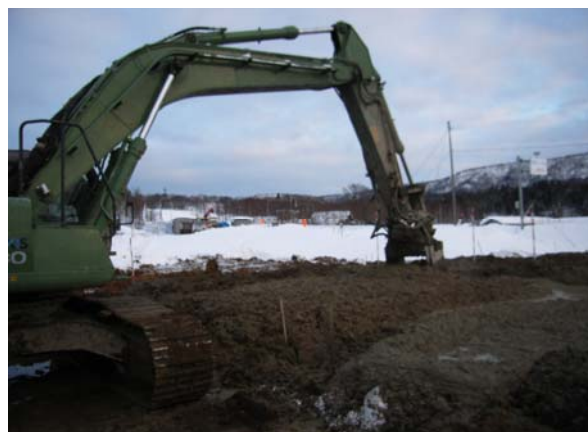
図-18 冬期施工の様子
