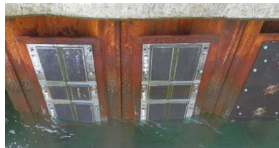
図-16 試験体の設置状況(暴露直後)
