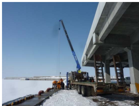
図-19 計測装置設置作業
