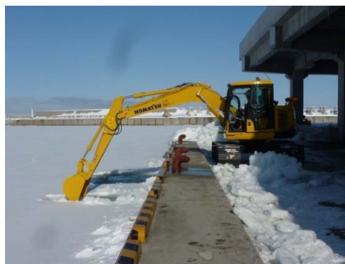
図-17 バックホウによる砕氷作業
