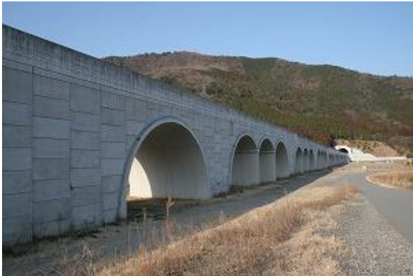
写真-1 連続アーチカルバート構造の事例 4)
