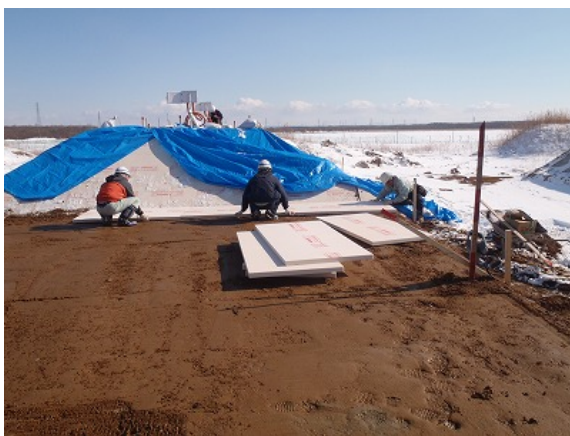
写真-4 断熱材施工状況
