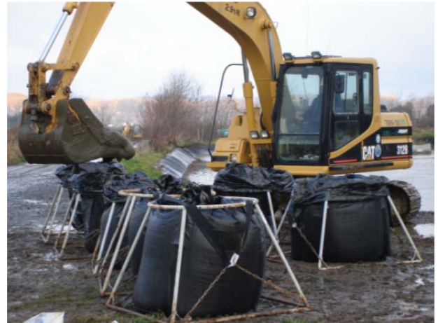
写真-8 土砂の投入状況
