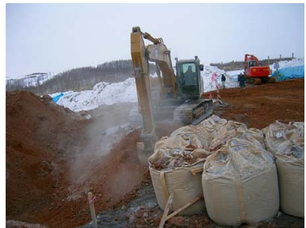
写真-7 現場試験施工
