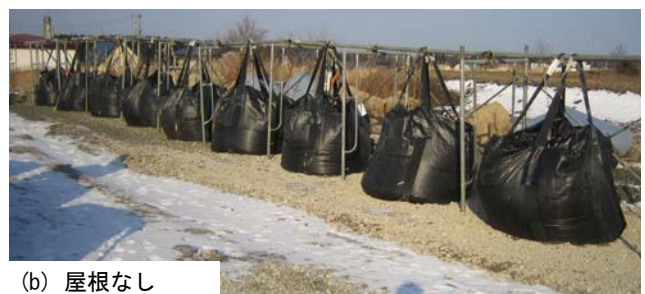
写真-9 大型土のう設置状況
