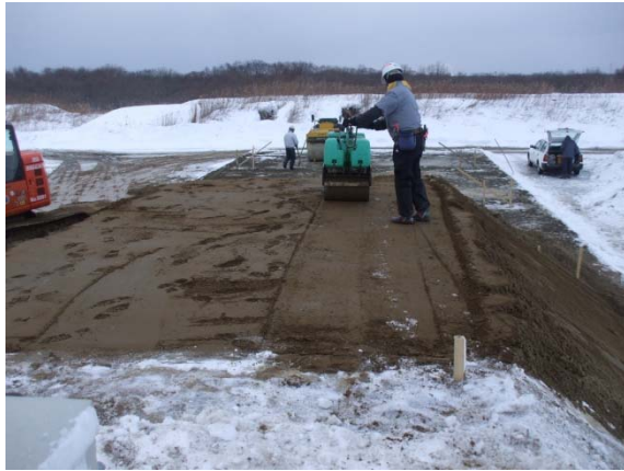
写真-3 試験施工状況
