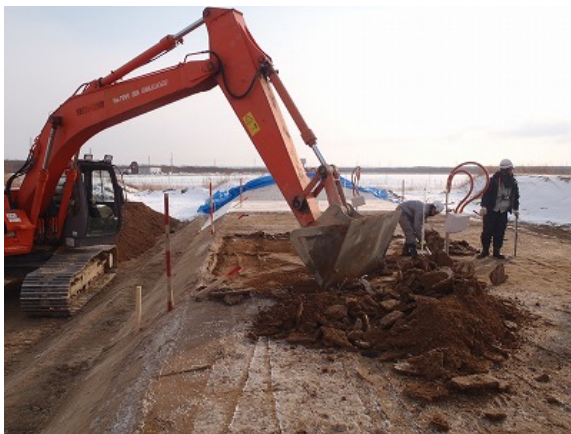
写真-5 凍土除去状況
