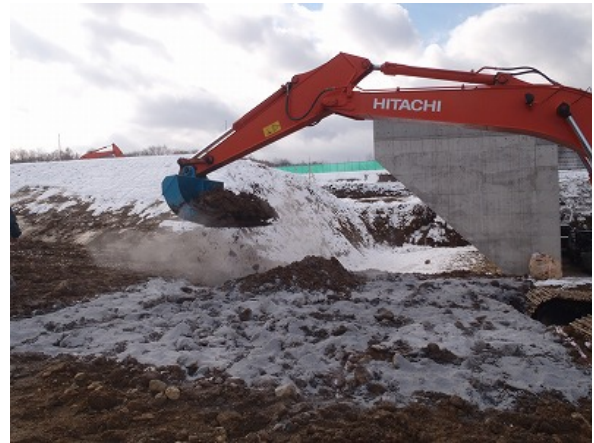
写真-6 冬期の固化材による改良
