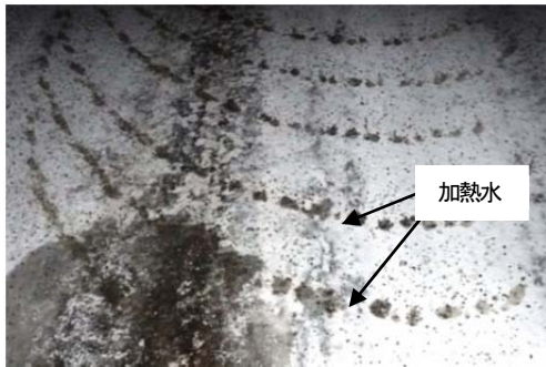
図14 加熱水混合散布後の路面状況
