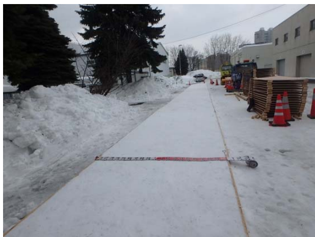
写真-5 雪氷路面作製状況
