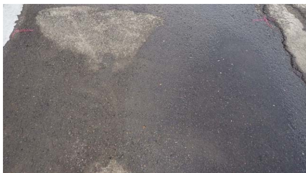
写真-8 破砕処理後に雪氷を撤去した舗装路面 (損傷はない)
