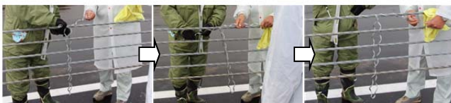
写真6 連結材の取り付け
