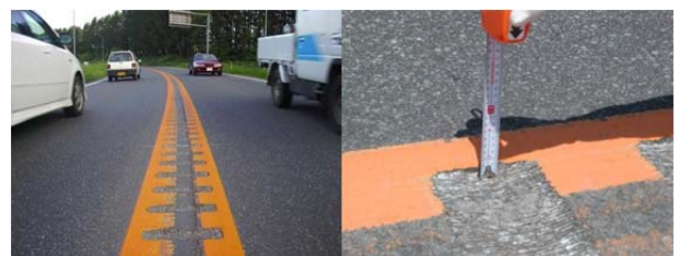
写真1 ランブルストリップス（左：R237、右：R275）
