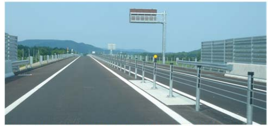
写真10 帯広尾自動車道の複合構造函渠工に設置されたベースプレート式中間支柱
