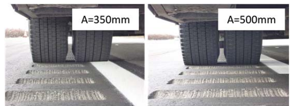
写真12 大型車対応ランブルストリップス (左: 幅350mm, 右: 幅500mm)
