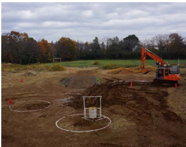
写真2 実験フィールド全景
