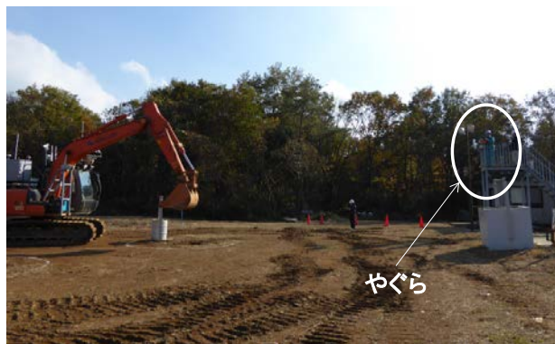
写真6 やぐらからの遠隔操作状況
