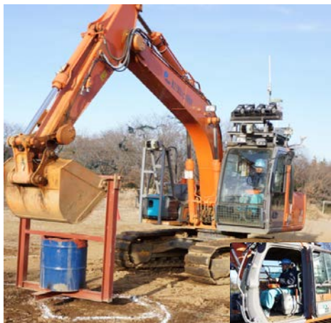
写真9 搭乗での遠隔操作状況
