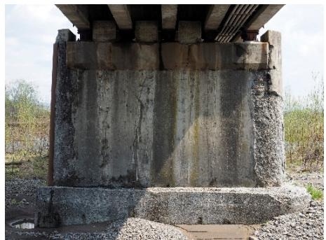
写真-1 鉄筋コンクリート橋脚の凍害等劣化状況
