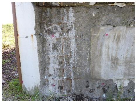
写真-2 かぶりコンクリート脆弱化状況
