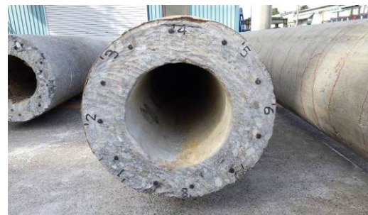
写真-2.2 試験体の切断後断面状況
