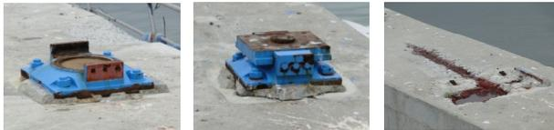
写真-3.1 津波の影響によって橋に生じた損傷のパターン
