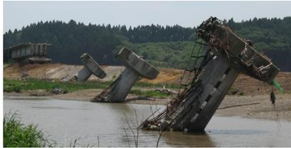
(b) 支承部が損壊して上部構造のみが流出した場合における支承部の様々な損傷パターン
