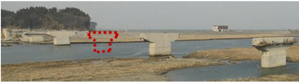
(a) 上部構造の流出とともに下部構造にも損傷が及んだ橋
