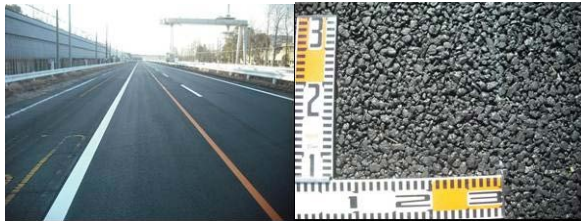
(a) 1 工区：排水性舗装（13mm トップ）
