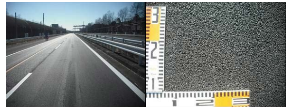
(b) 2 工区：低燃費型排水性舗装（5mm トップ）
