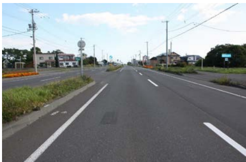
写真-4-1 供用11年後の鉄鋼スラグ工区の状況
