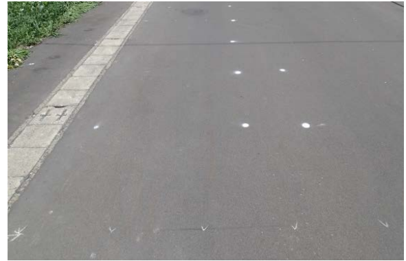
写真-2-1 供用4年後の焼却灰再生資材工区
