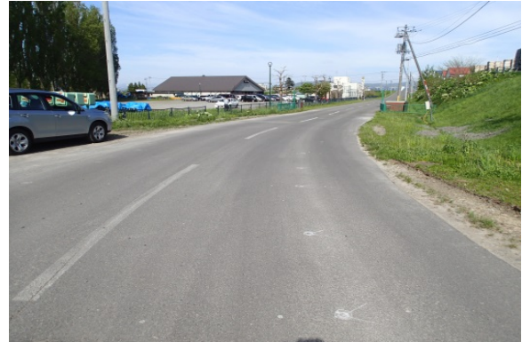
写真-1-1 供用5年後のガラスカレット工区の状況
