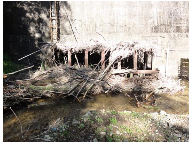
図 3.25 嵯峨谷ダム上流側スクリーン
