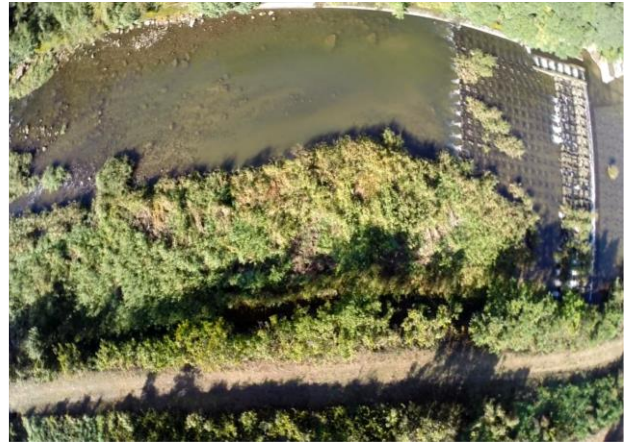
図 3.14 現地調査地点②空撮 (右側上流)
