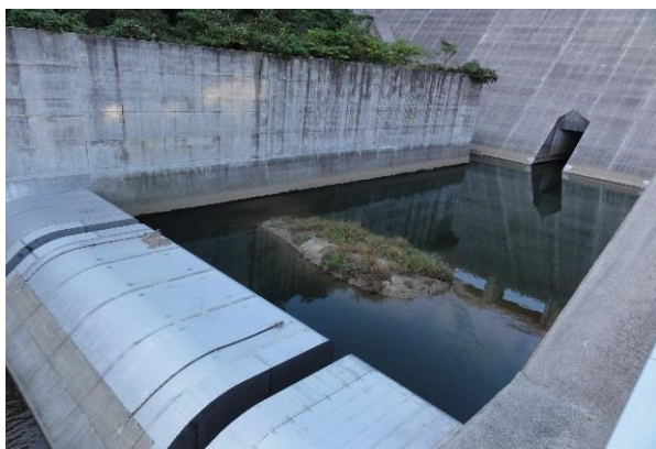
図3.16 現地調査地点③下流近景
