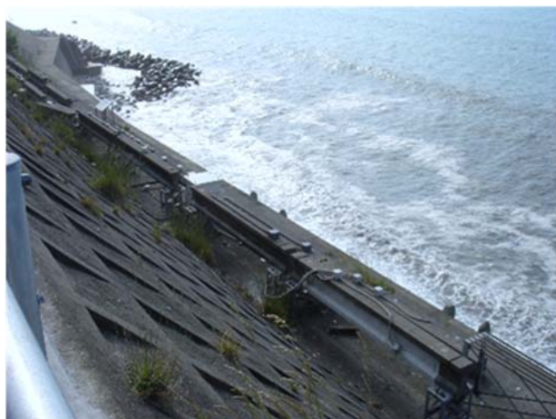
写真-1 新しい陽極システムの暴露試験(市振海岸)
