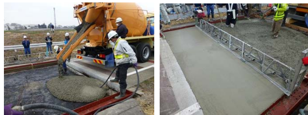
写真 4-1 試験施工状況
