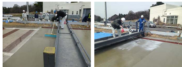
写真 4-2 試験施工状況 (粗面仕上げ)
