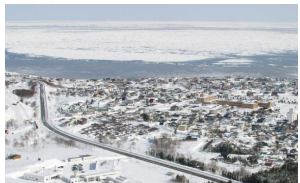
図-5 防氷柵による海水の制御状況
