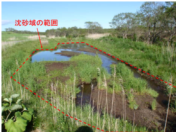
写真-1 水質浄化池B-1の観測開始時点での土砂堆積状況 (2011年6月撮影)
