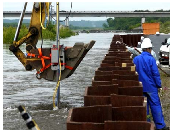
図-17 模擬空洞 (上) と試験状況 (下)
