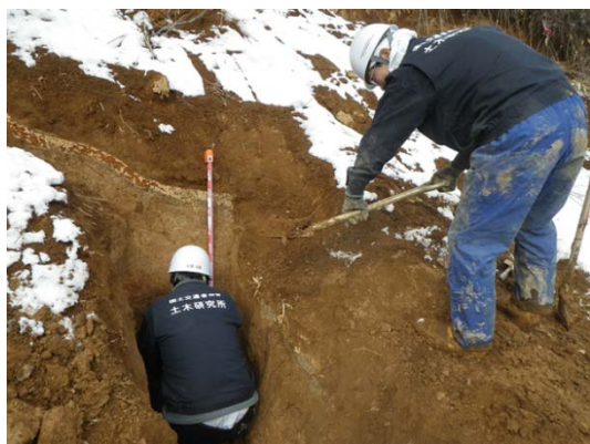
写真-1 すべり面調査状況
