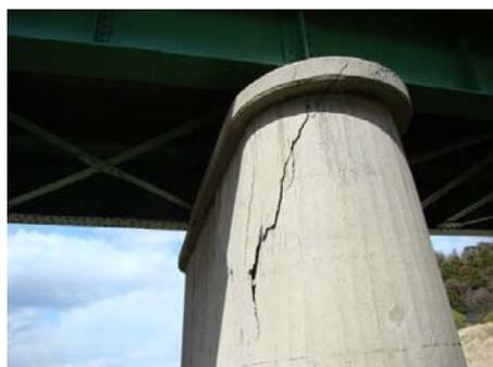
写真-3 壁式橋脚における橋座部のせん断破壊<sup>10)</sup>
