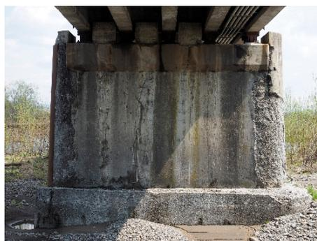
写真-1 鉄筋コンクリート橋脚の凍害等劣化状況
