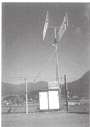
図-19 調査地内に設置した受信局
