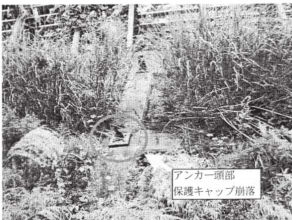
写真-4 アンカー頭部保護キャップの崩落 (E地区、調査日 H17. 10. 24)
