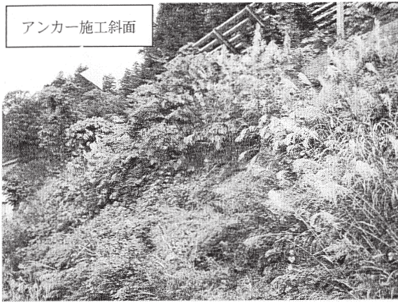
写真-2 アンカー施工斜面の状況 (E地区、調査日 H17. 10. 24)
