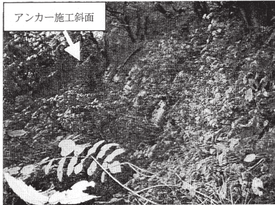
写真-3 アンカー施工斜面の状況 (F地区、調査日 H17. 11. 16)
