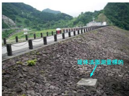
写真-3 フィルダム堤体下流側の可動標的
