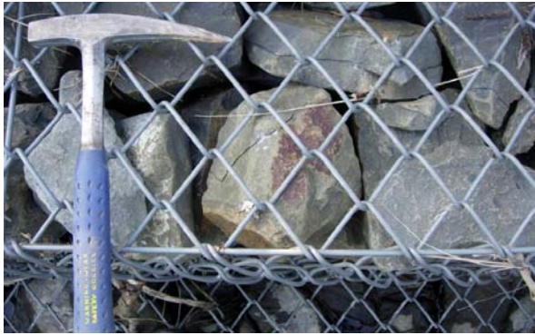
図-6 亀裂の入った細粒砂岩
