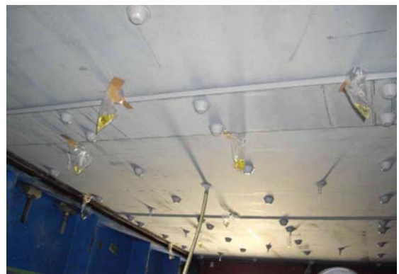
図-8 供試体 NS1 の鋼板接着補強の施工 (樹脂注入作業)
