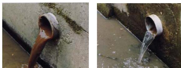
写真8 暗渠管の排水口からの排水状況<sup>19)</sup>
