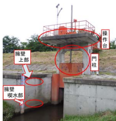
写真-2.1 樋門の調査部位
