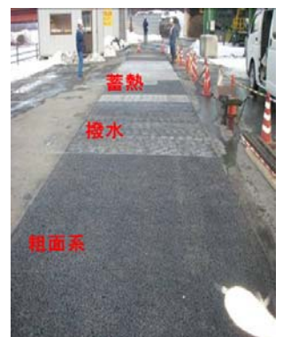
写真-16 施工後の状況
