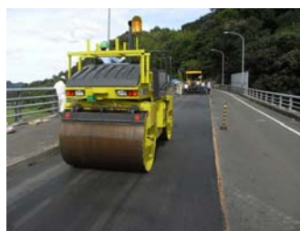
写真-5 施工状況
