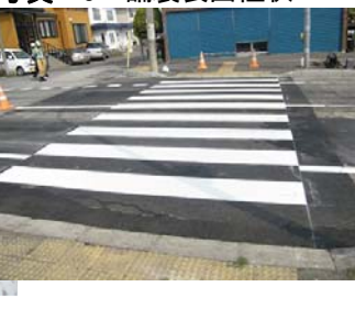
写真-10 舗装完了状況
