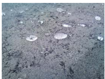
写真-4 撥水舗装の表面
