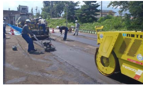
写真-13 施工状況
