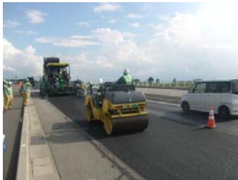
写真-7 施工状況
