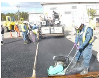
写真-4 施工状況
