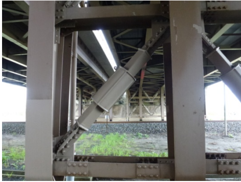
写真-1 鋼材降伏系ダンパーの例
