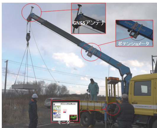
写真-2 コンクリートブロック誘導試験
