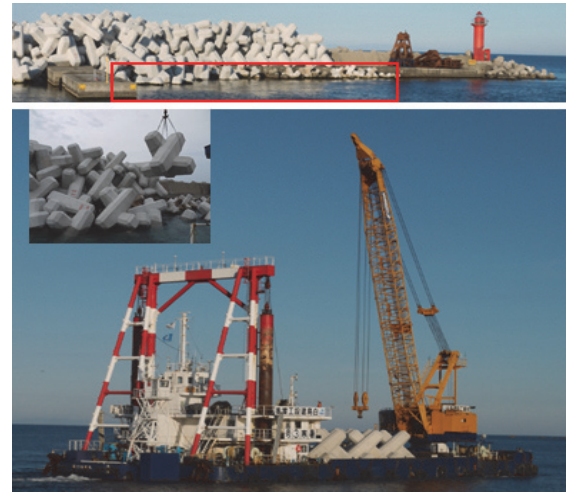
写真-3 試験海域・使用船舶・据付作業
