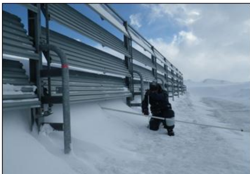
写真-2 下部間隙付近の積雪深の計測
