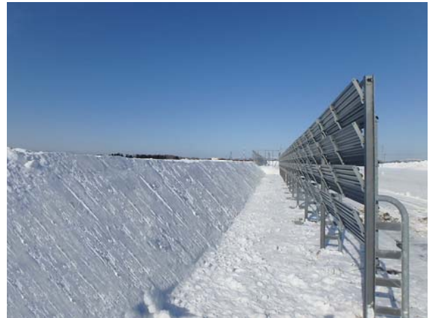
写真 - 3 吹き払い柵風上に作成した疑似切土
