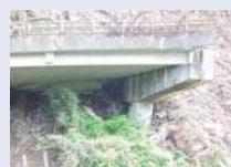
急斜面に設置された単列杭基礎が傾斜、耐荷力の低下
