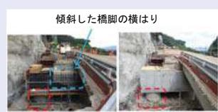
増し杭により耐荷力を回復させるとともに、斜面と地盤構成を考慮して杭の複列化により、致命的な状態になりにくい構造
