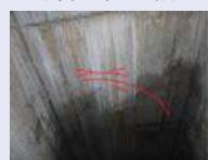
中空断面を貫通しているひび割れ、耐荷力の低下
