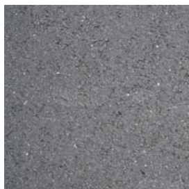
通常舗装 (密粒度アスファルト舗装)
