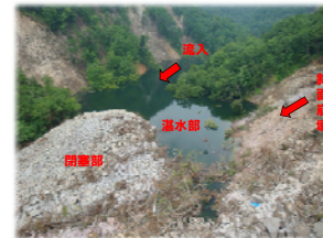
湯浜地区天然ダム状況
