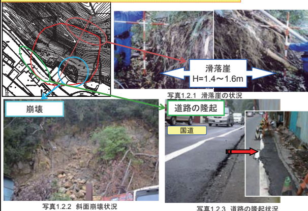
写真1.2.2 斜面崩壊状況
