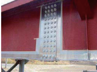
チタン箔シート貼付完了
