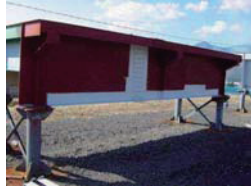
チタン用プライマー塗付後
