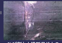
ひび割れと横断目地との組合せで半月状にブロック化
