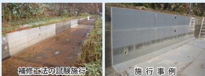
農業用コンクリート水路(開水路)の中には、建設後数十年を経過し、徐々に老朽化が進んでいるものがあります。水利基盤チームでは、施設の長寿命化によるライフサイクルコストの低減を図るため、寒冷地に適した補修技術の開発を行っています。本講演では、寒冷地の農業用開水路に適用できる補修技術に関する取り組み・検証事例を紹介いたします。
