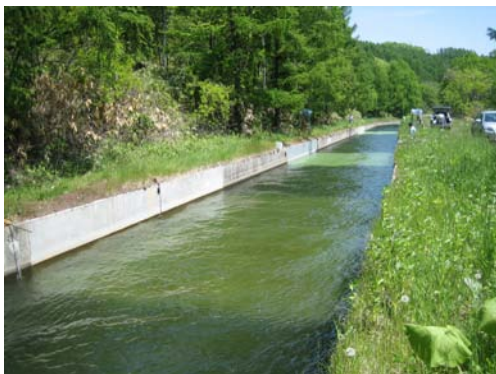
試験施工区間の状況(施工後)
