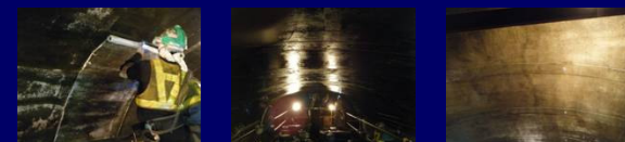
4. NAVシート貼り付け
