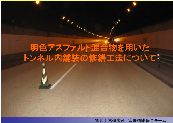
寒地土木研究所 寒地道路保全チーム
