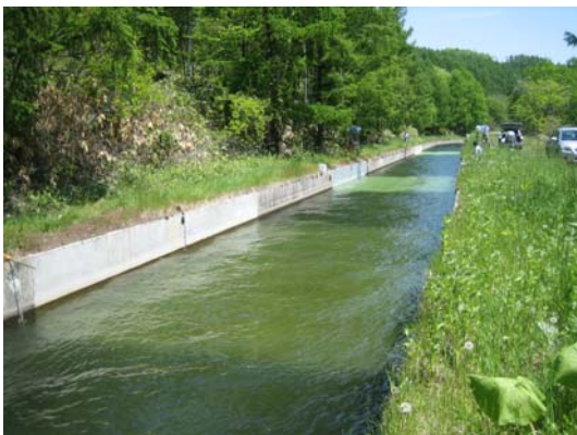
試験施工区間の状況(施工後)
